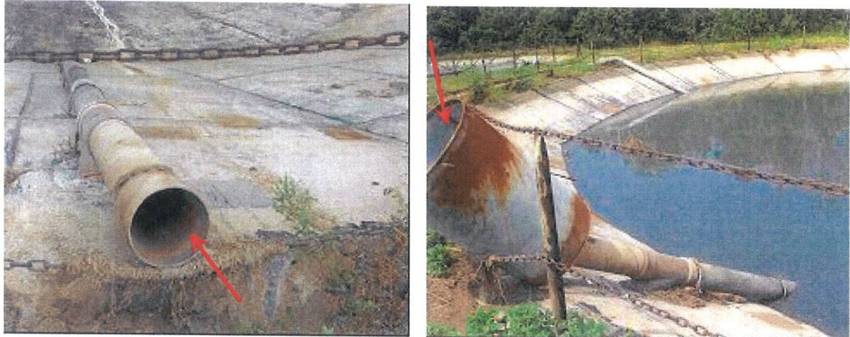
Abbildung 4 Vorhandenes Rohr, in das der flexible Schlauch eingebracht wird
