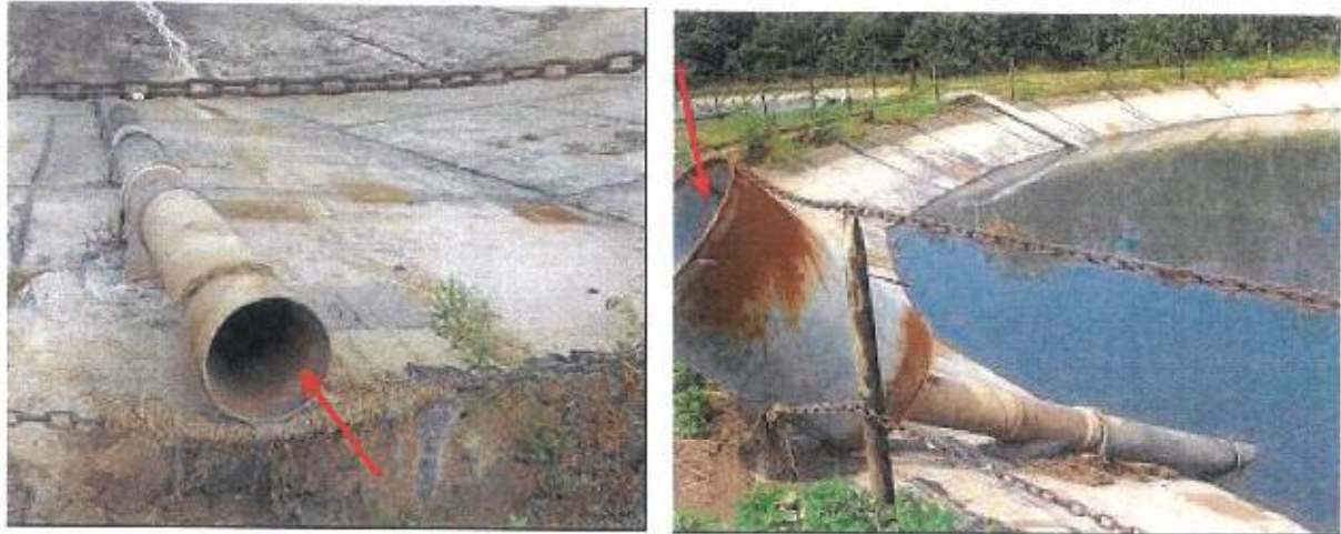
Abbildung 4 Vorhandenes Rohr, in das der flexible Schlauch eingebracht wird
