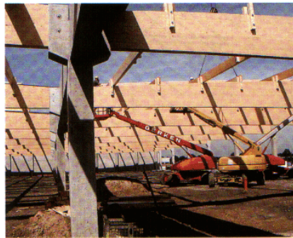
Rohbau der Halle Foto: Derix Holzleimbau
