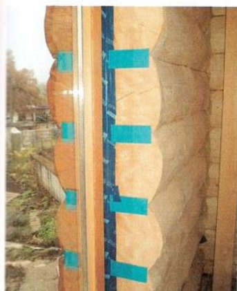
Luftdichter Anschluss des Fensters in der Blockhauswand
