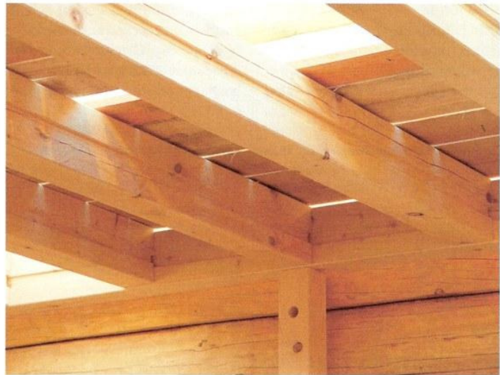
Im Rohbau: Schalltechnisch entkoppelte Konstruktion der Decken
