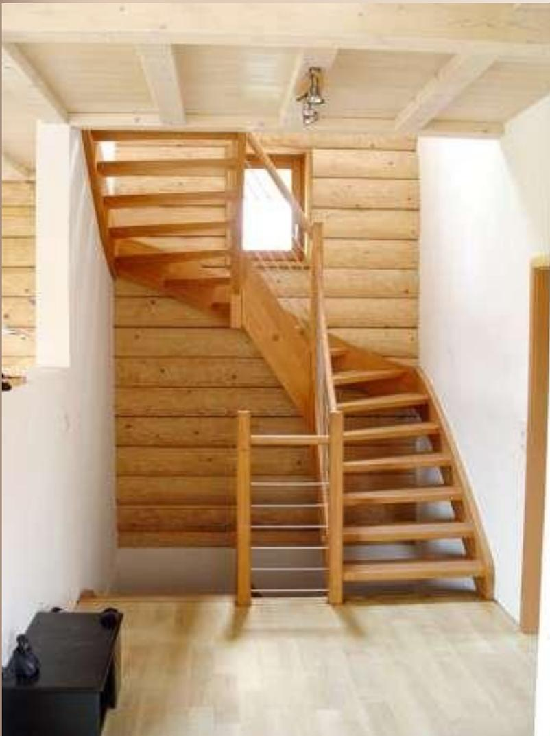
Die eingestemmte **Treppe** aus 100% massiver **deutscher** Buche ist innerhalb der Innenkonstruktion montiert. Damit ist sie ebenfalls zu 100% von der Blockwand entkoppelt.
