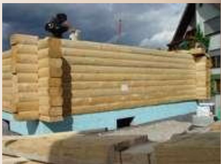
Sehen Sie die Wandstärke, die Fremdfeder und die Eckverkämmung (- da fährt kein Panzer durch).
